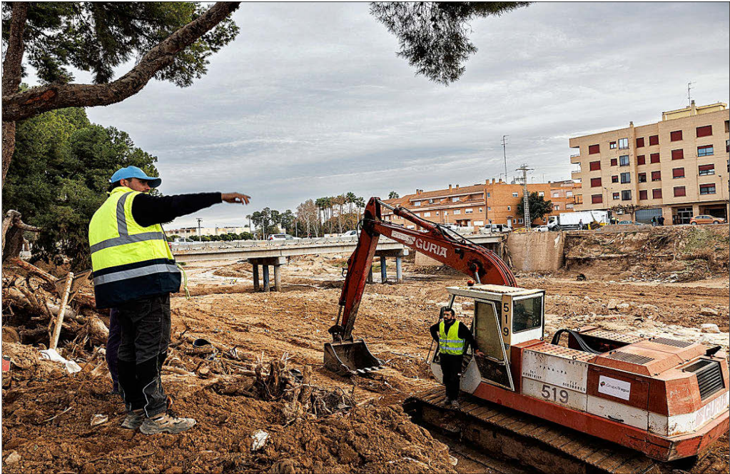
Operarios en el barranco del Poyo (Paiporta) en diciembre de 2024, un mes después de la dana. CARLOS GARCÍA POZO
