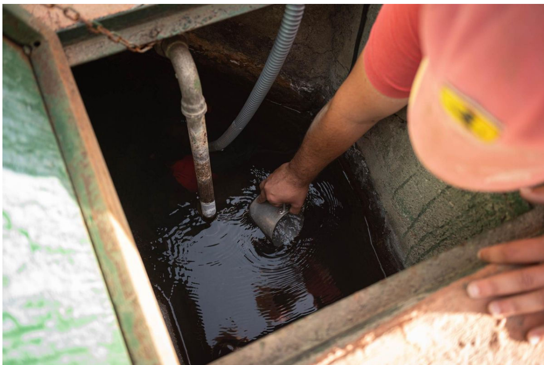
Agua extraída de una de las dos galerías de Vergara, en La Guancha, las que dan más caudal de toda Canarias.
